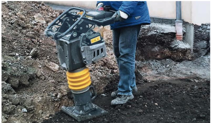
\*Les pilonneuses BOMAG équipées d'un moteur essence Honda GXR-120 (BT 60 et BT 65) peuvent aussi être utilisées dans des tranchées d'une profondeur allant au-delà de l'épaule et présentant une largeur minimum de 1,5 m. Plus d'informations sur : [www.bgbau.de](http://www.bgbau.de) (BG Bau, Allemagne, 2015).
